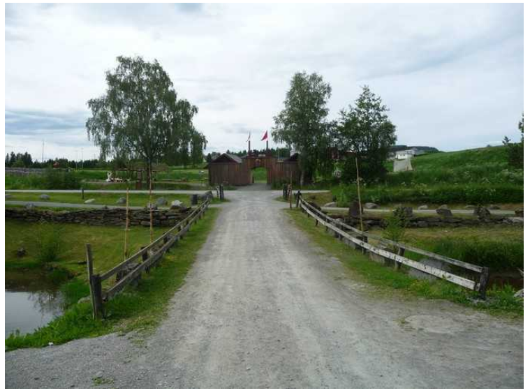
A bridge across Molåna.
